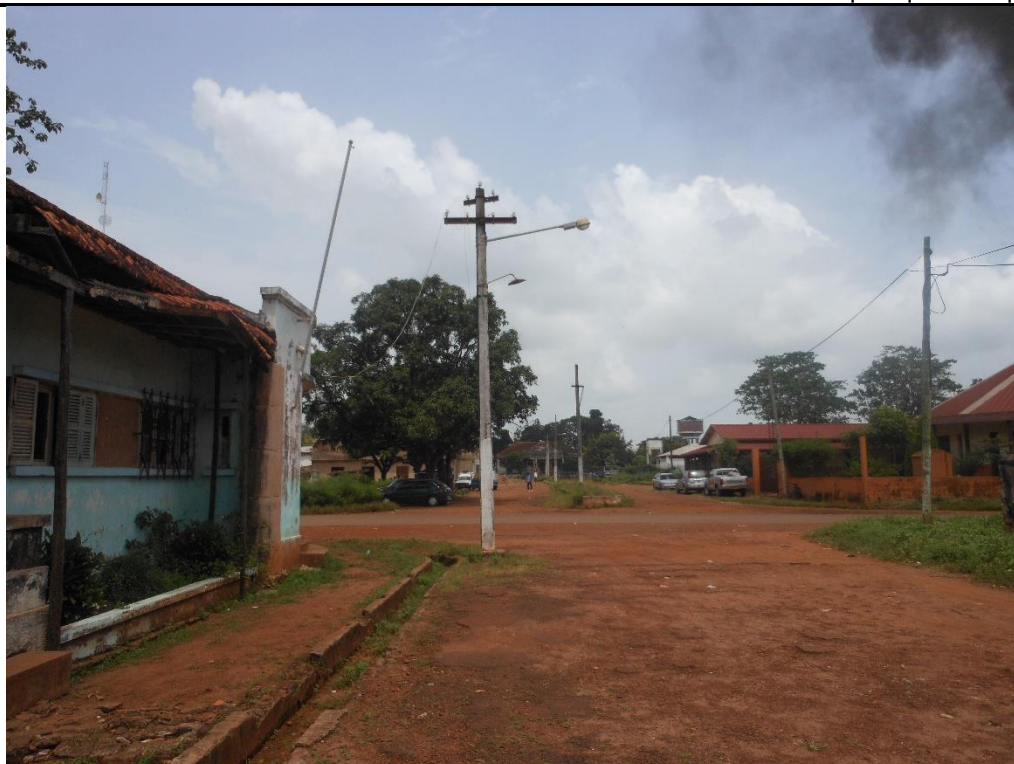
Figura 10 - Mansoa, encontro do traçado preexistente com a ampliação do período do Estado Novo (à esq. sede dos correios, ao fundo uma das habitações de funcionários e caixa-de-água). Foto: Ana Vaz Milheiro, 2011.
