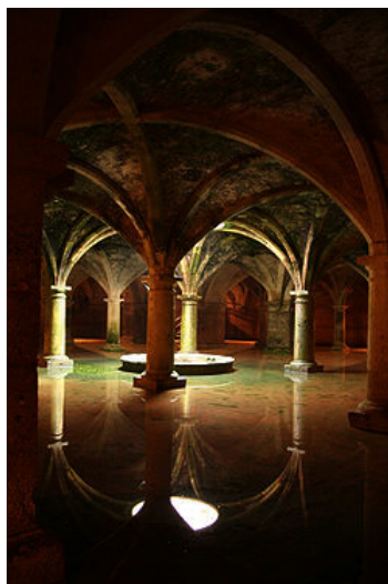
Fig. 4 - Cisterna Manuelina, Mazagão
