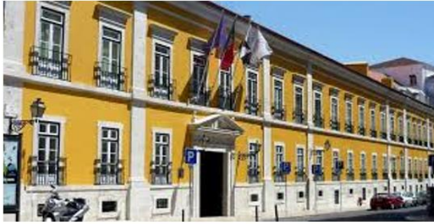
Figura 1 – Fachada exterior da UAL.
