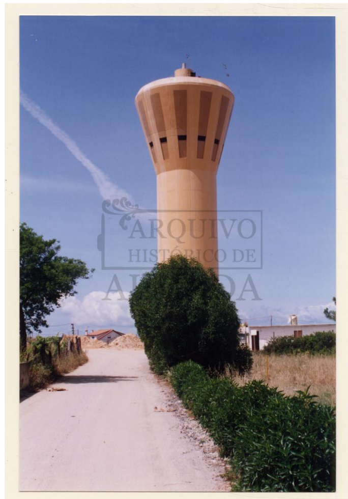
Image 85. Reservatório Elevado do Laranjeiro [Photograph].(2009).
