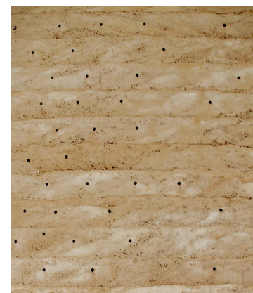
(acima) Fig.39 matéria: detalhe construtivo, do espaço. Betão bojardado, mistura terra e outras matérias-primas naturais.
