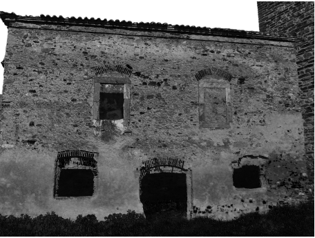
Figura 41: Casa dos Oficiais
