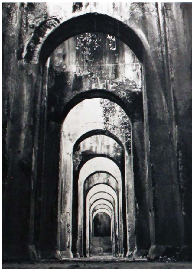
006| Piscina Mirabilis - Napoli. Vista de uma das longas galerias
