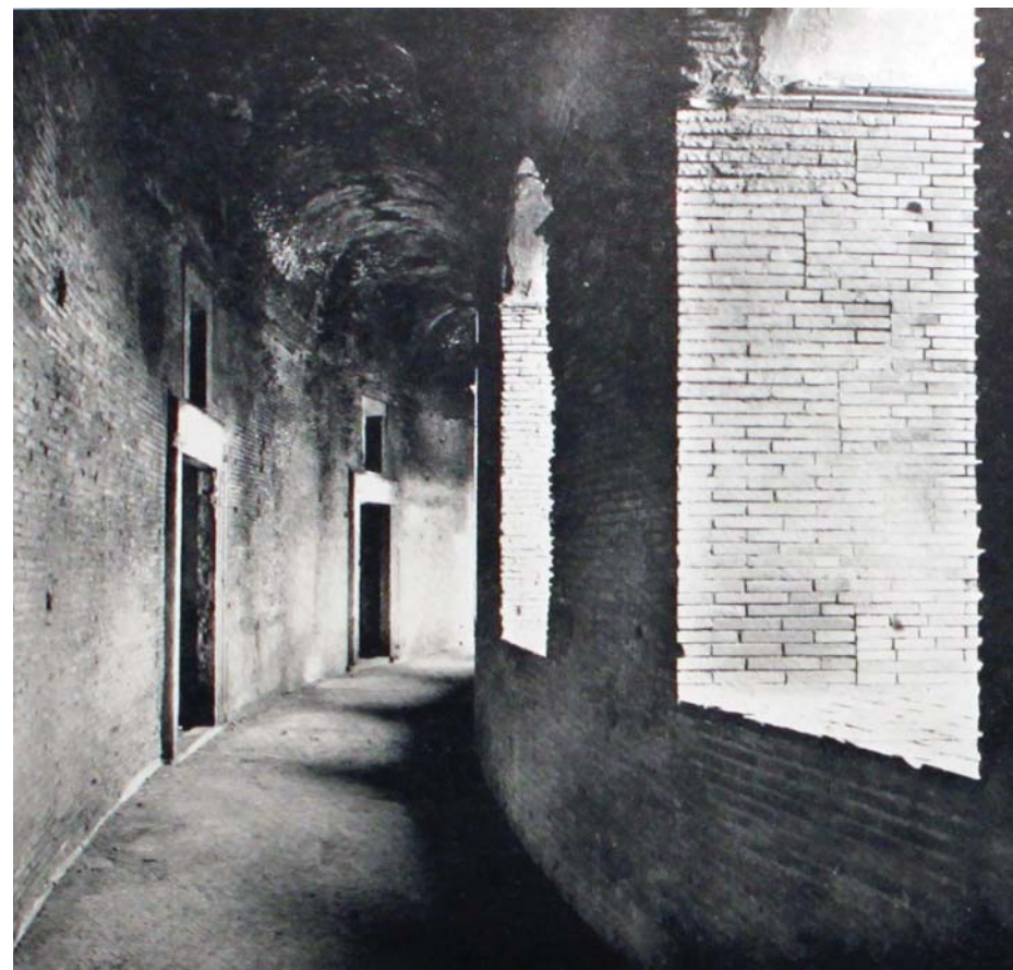
007| Mercado Traiani - Roma. Ruas comerciais em arcadas no segundo piso
