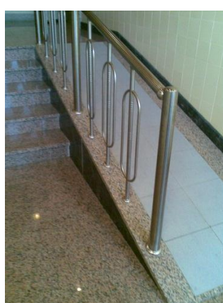
Imagem n.º21 (Prédio urbano para habitação construído depois de 2000-Portugal)
