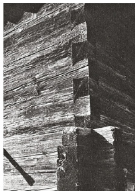
Fig.30 | Primeiros métodos de construção na Europa - Cantos Entalhados
