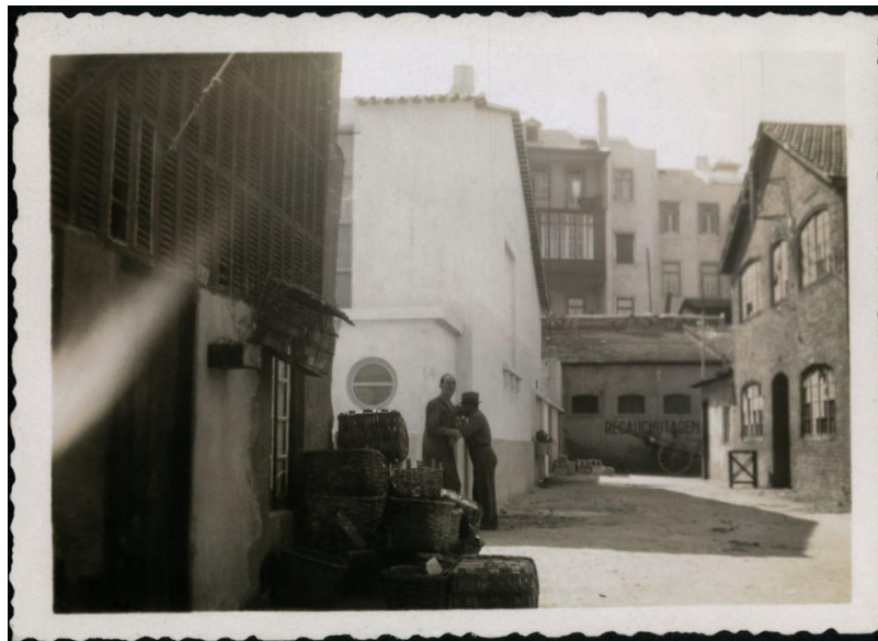
Fig. 5.15 – Espaço antigo do “Pátio dos Artistas” - Rua Coelho da Rocha, nº 69 Arquivo da Fundação Calouste Gulbenkian. s. d.
