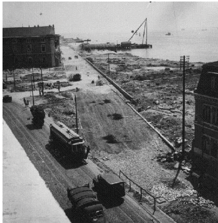
028 CONSTRUÇÃO DA AV. RIBEIRA DAS NAUS, 1939, LISBOA
