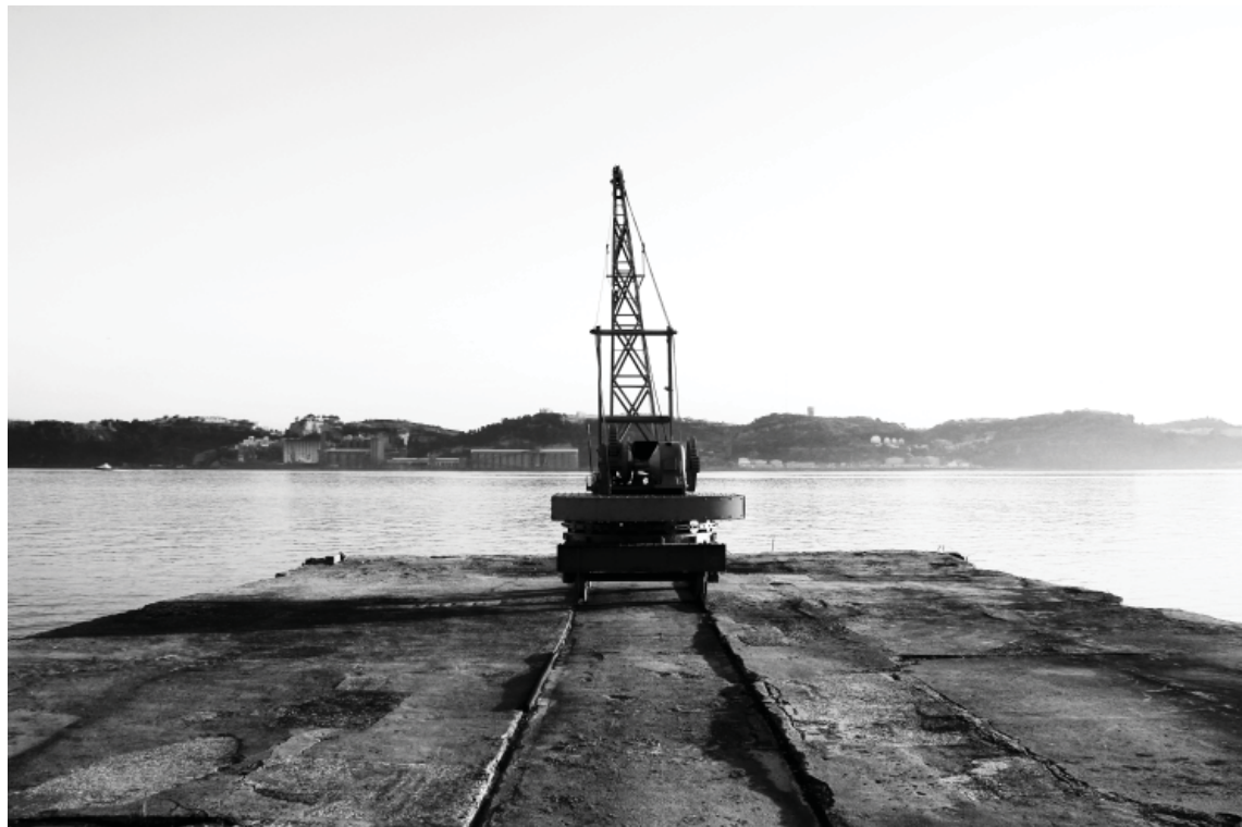
023 GRUA DESACTIVADA PERTENCENTE À ANTIGA CENTRAL TEJO, LISBOA
