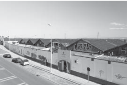
017 VESTÍGIO DE EDIFÍCIO FABRIL PERTENCENTE AO PORTO DE LISBOA, SANTOS
