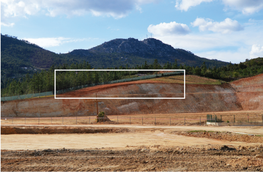
Localização de Cobrinhos depois da escavação arqueológica e já durante a escavação para a ampliação da fábrica AMS-BR STAR PAPER, S.A.. Fotografia de Telmo Pereira.
