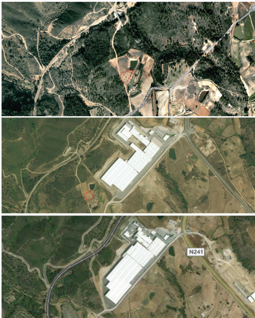
Três imagens de satélite com a localização de Cobrinhos antes e depois dos trabalhos de ampliação, em 2006 (topo), 2014 (meio) e 2019 (base). Imagens: Google Earth.
