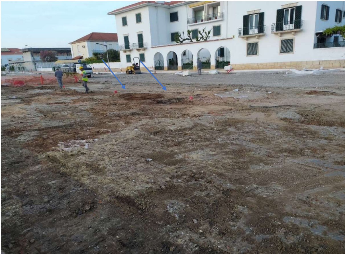
Figura 12 - Decapagem obra requalificação da Várzea Grande (Tomar), em que se verificam várias manchas no solo – Foto Vanda Luciano.
