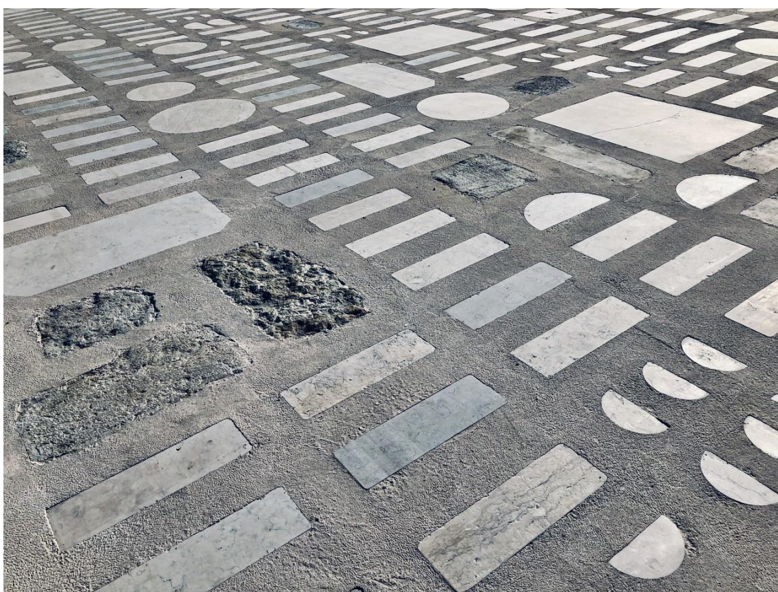
Figura 4 - Campo das Cebolas - Pavimento com incorporação de elementos pétreos existentes e resultantes de escavação arqueológica (Victor Beiramar Diniz, 2019).
