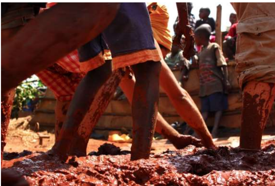
Figura 7 – WNA, fase 2 – preparação de terra
