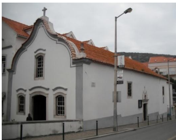
Figura 24 – Capela da Santa Casa da Misericórdia (Foto da autora, Dezembro 2012)
