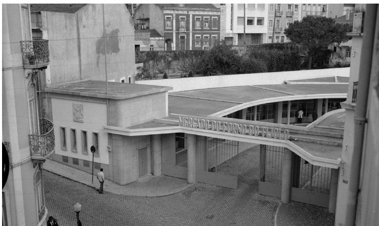
fig. 47 _ Entrada do Mercado do Forno do Tijolo, 1956
