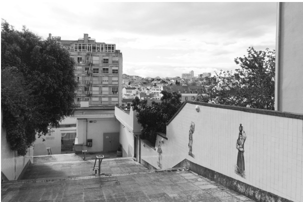
fig. 60 _ Escadas de acesso secundário ao Mercado do Forno do Tijolo
