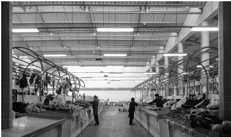
fig. 53 _ Interior do núcleo central, Mercado do Forno do Tijolo, 2013
