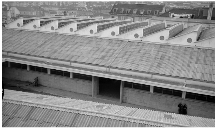
fig. 48 _ Pormenor da cobertura do núcleo central do Mercado do Forno do Tijolo, 1956
