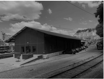
09 - ANTIGO EDIFÍCIO PERTENCENTE A ESTAÇÃO DE ALCÂNTARA-TERRA, ONDE O MESMO FOI RESTAURADO E ATUALMENTE É TOMADO POR ESCRITÓRIOS.
