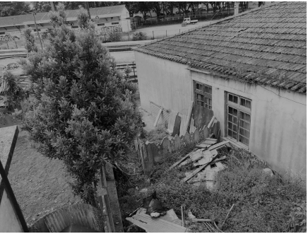
07 - EDIFICAÇÕES DESATIVADAS E ABANDONADAS AO REDOR DAS LINHAS FÉRREAS NA ESTAÇÃO DE ALCÂNTARA-TERRA.
