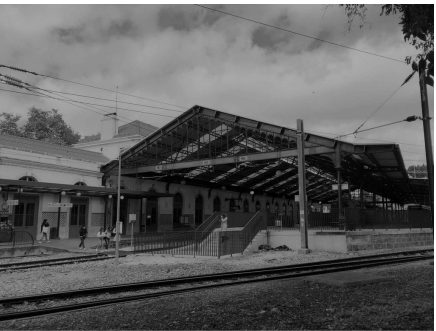
10 - COBERTURA DESTINADA AO ACESSO PARA OS COMBOIOS NA ESTAÇÃO. SEJA PARA EMBARQUE OU DESEMBARQUE.
