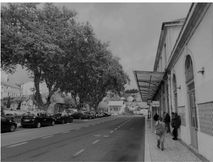
01 - EDIFICAÇÃO PRINCIPAL DE ALCÂNTARA-TERRA, ONDE ATUALMENTE É TOMADA POR ESCRITÓRIOS RELACIONADOS AOS COMBOIOS.
