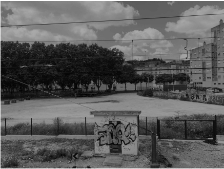
05 - TERRENO VAZIO PERTENCENTE A ESTAÇÃO DE ALCÂNTARA-TERRA.
