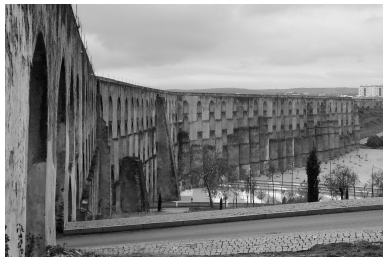
Fig. 13 AQUEDUTO DA AMOREIRA . ELVAS
