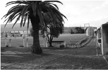
Fig. 67 RESERVATÓRIO DE ÁGUA CAMPO DE GOLFE DAS AMOREIRAS
