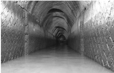
Fig. 03 INTERIOR DO AQUEDUTO AQUA APPIA
