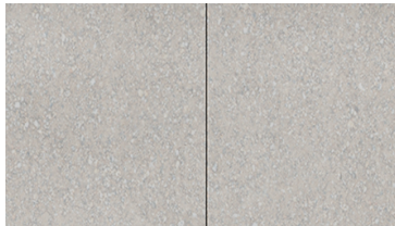
Fig. 71. Lajetas de betão pré-fabricado Espaço Público
