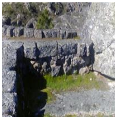
Figura 50 - Base da Torre de Menagem (foto da autora)
