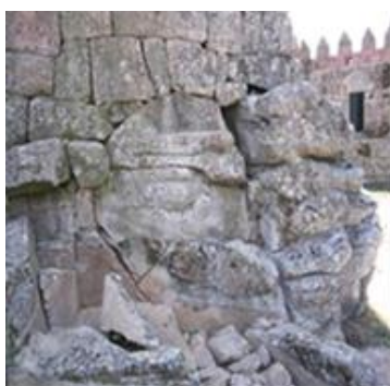
Figura 74 - Base da Torre de Menagem do Castelo (foto da autora)
