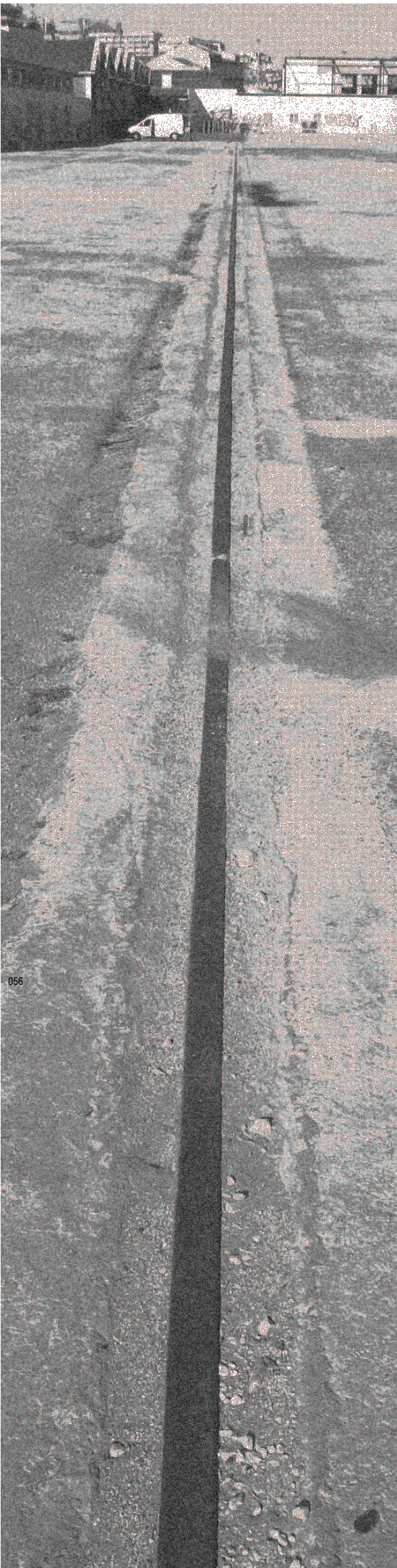
27. Antigos carris destinados às gruas para cargas e descargas
