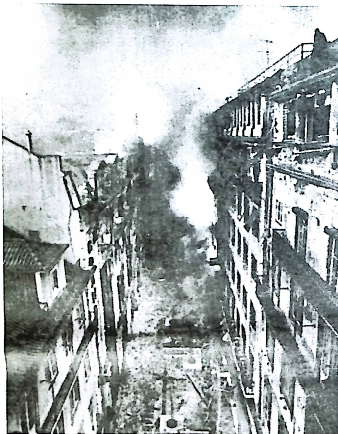
Fig. 3 - O incêndio no Chiado (1988).
