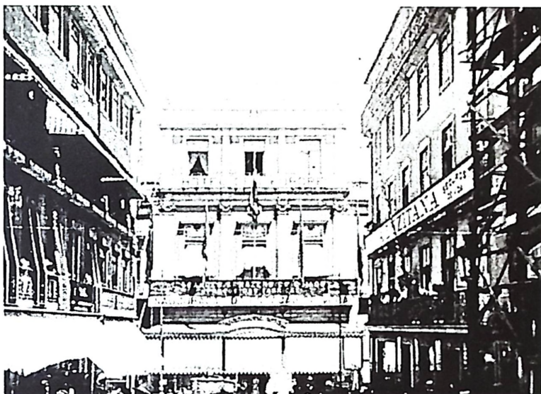
Fig. 5 – Os Armazéns do Chiado e o Hotel de l'Europe.
