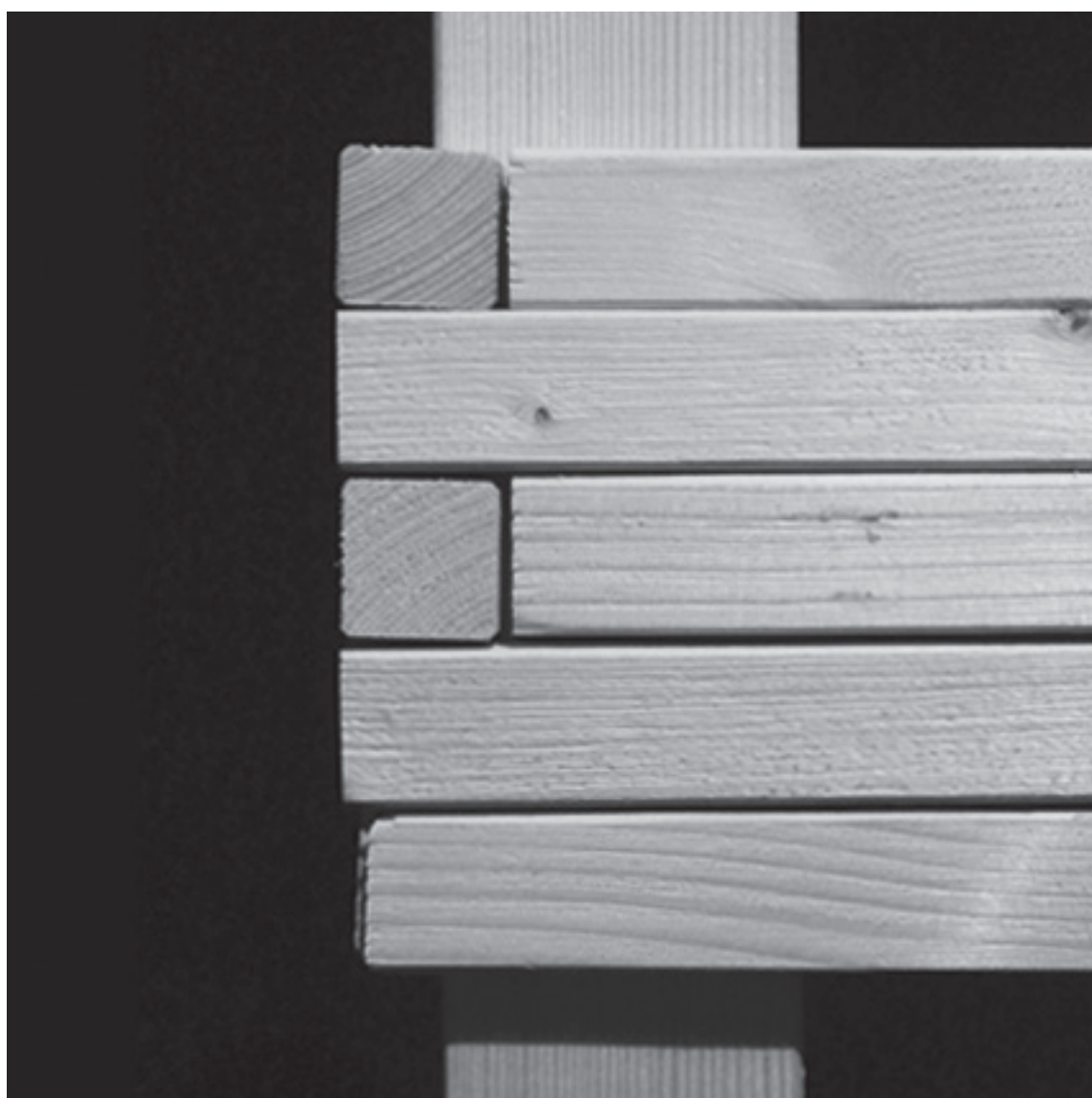
Dettaglio dell'incastro della struttura realizzato in legno - 1:5
