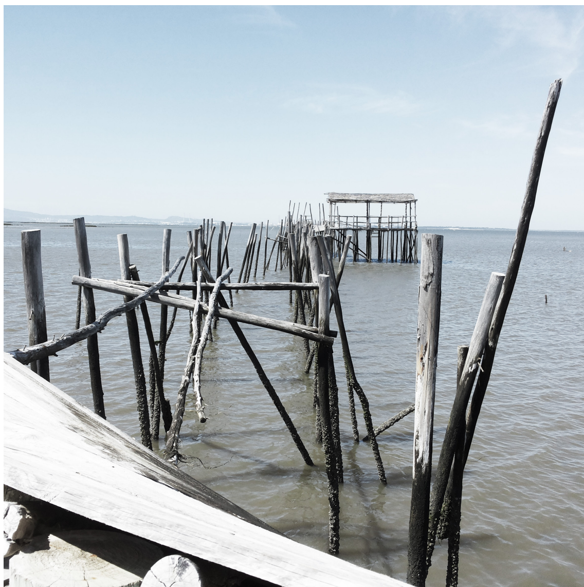
figura 33: Fotografia del porto palaffitino di Carrasqueira nella sua parte più esposta al fiume Sado - Portogallo 2014
