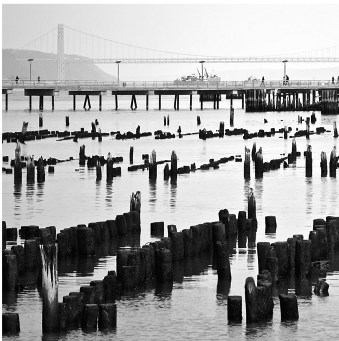
figura 20: Resti della ferrovia New York Central Yard - West Side di Manhattan 2005
