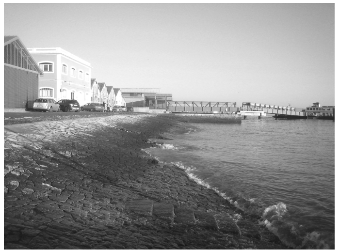
68.Fotografia do muro de lioz . rampa, escadas e pontão . Maria Macedo, 2010
