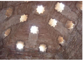
106.Alhambra, entrada de luz na cobertura
