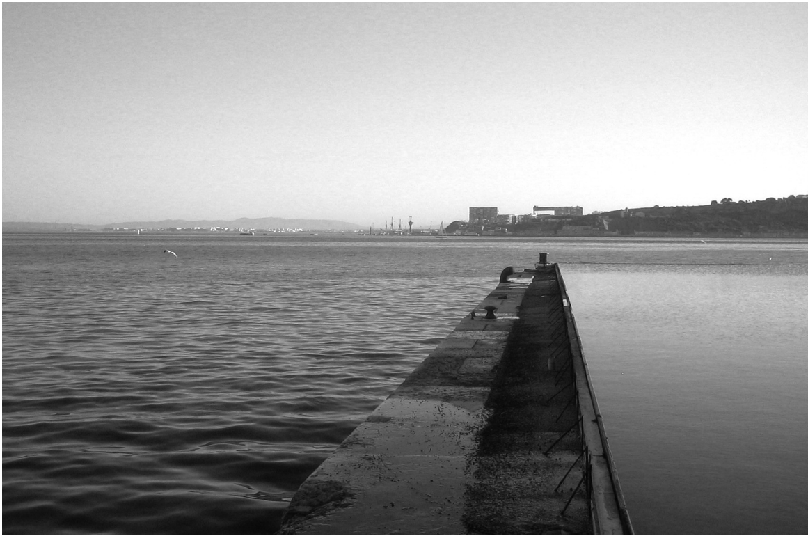
85.Espelho de água existente no Urban Beatch. rio|muro de lioz| tanque . Maria Macedo 2010
