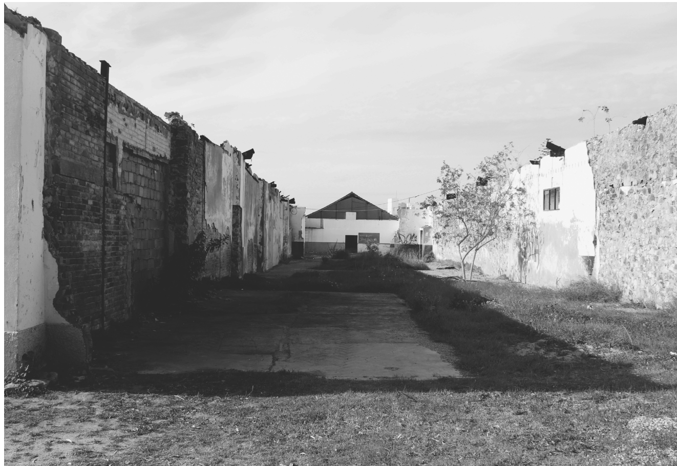
Fig. 20. Edifícios devoluto no Parque Desportivo Municipal João Martins, Sines
