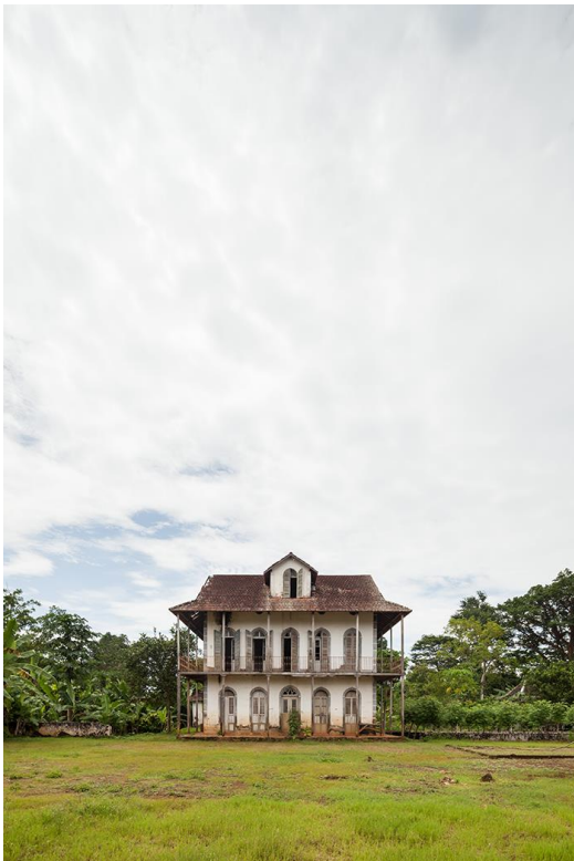
Fig. 4 - Nova Olinda, Casa da Administração [fotografia: Francisco Nogueira]
