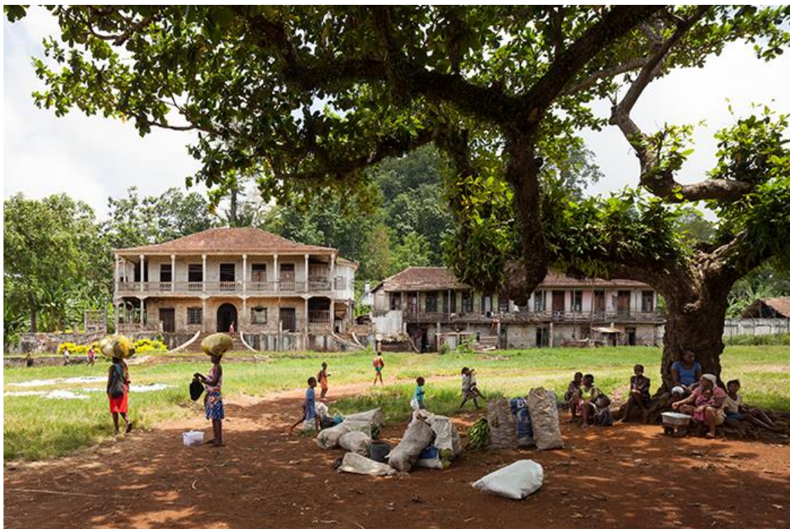
Fig. 3 - Uba-Budo, Casa da Administração [fotografia: Francisco Nogueira]
