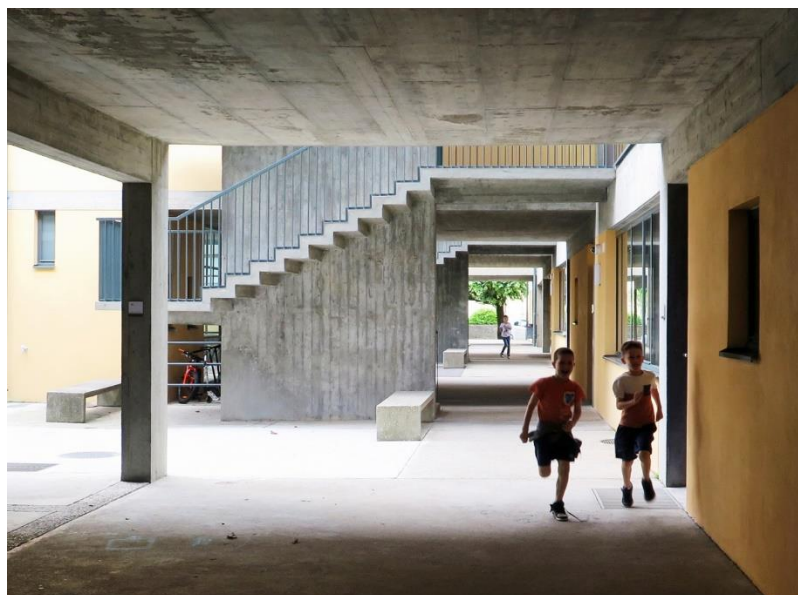
Figura 13 – Escola Primária Riva San Vitale, vista atravessamentos longitudinais (Fonte: Fotografia da autora, 2024).
