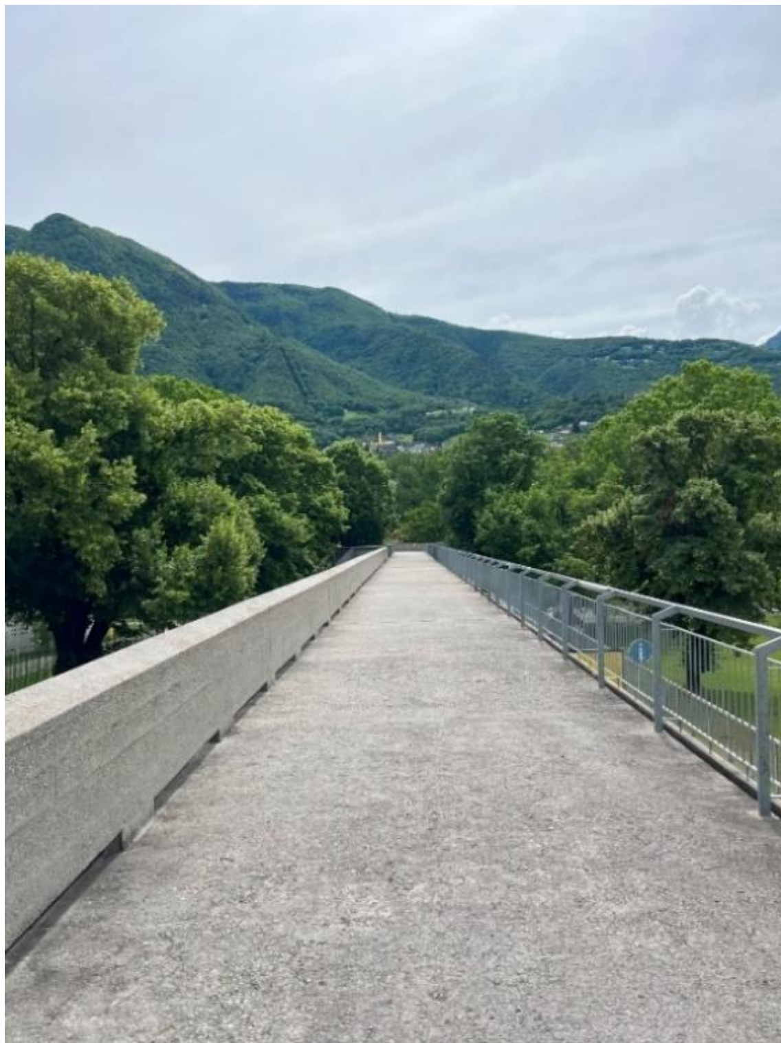
Figura 72 – Vista do passadiço.
