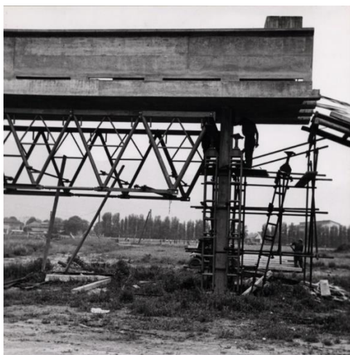
Figura 52 – A construção do passadiço, 1969. Nota-se o detalhe do encaixe de cada parcela, executada in loco, assim como a treliça de ferro, para cofragem da mesma (Fonte. Archivo del Moderno, ALG, AUTCB). Figura 53 – A construção da estrutura metálica, 1969 (Fonte. Archivo del Moderno, ALG, AUTCB).
