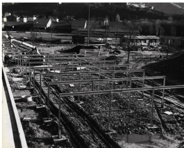
Figura 52 – A construção do passadiço, 1969. Nota-se o detalhe do encaixe de cada parcela, executada in loco, assim como a treliça de ferro, para cofragem da mesma (Fonte. Archivo del Moderno, ALG, AUTCB). Figura 53 – A construção da estrutura metálica, 1969 (Fonte. Archivo del Moderno, ALG, AUTCB).
